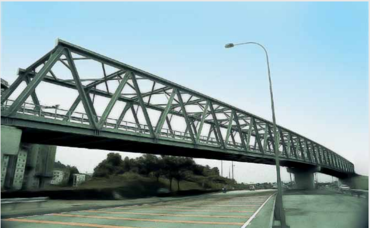
Kuala Lumpur LRT Bridge, Malaysia
